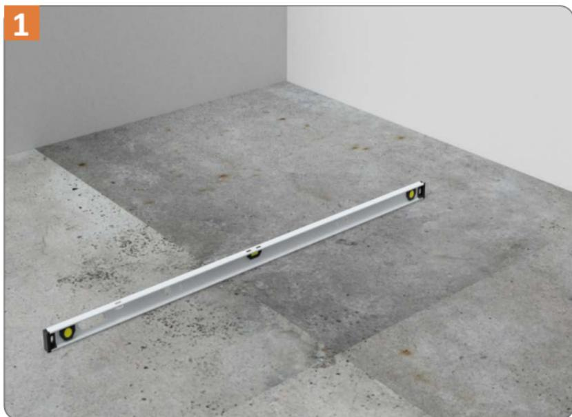
El suelo debe estar limpio y seco y, si es necesario, alisado con un compuesto autonivelante para dar una superficie uniforme.
